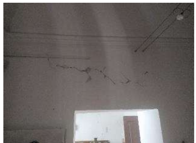
1K-04....Horizontalna pukotina iznad nadvoja otvora (š<1 cm)
