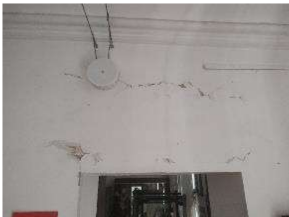
1K-03....Horizontalna i dijagonalne pukotine nadvoja otvora
