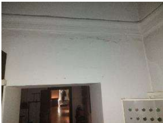
1K-13....Male horizontalne pukotine iznad nadvoja otvora
