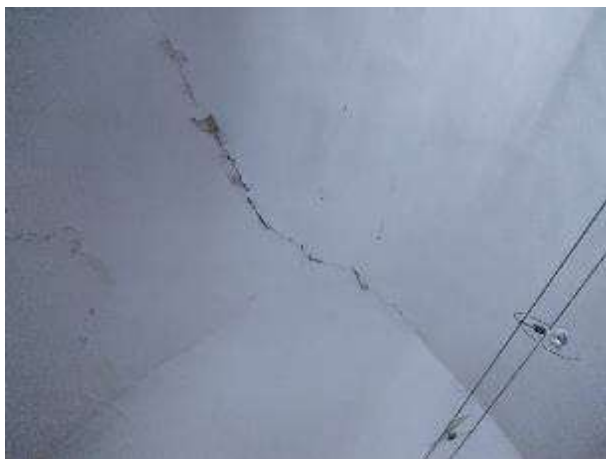
1K-01.....Oštećenja lučnog svoda. Dijagonalne pukotine 1 cm
