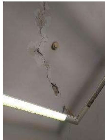
1K-20...Značajne pukotine lučnog svoda ureda ravnateljice
