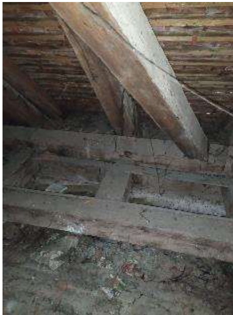
Krovište sa detaljom oslanjanje nazidne grede na zidani vanjski nosivi zid – oštećena cigla zida
