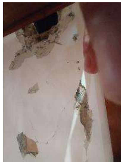
1K-21...Otvori i značajne pukotine uz nosivi zid izloženog prostora. Otvor ispod pete luka svoda nastao u potresu zbog oslabljenja zida zbog dimnjaka.
