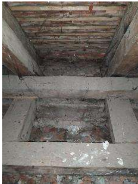
Krovište sa detaljom oslanjanje nazidne grede na zidani vanjski nosivi zid – oštećena cigla zida
