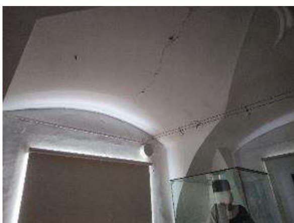
1K-09....Male pukotine do 0,5 cm u svodu nadvoja prozora
