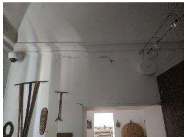
1K-02....Horizontalna pukotina iznad nadvoja otvora (š<0,5 cm)
