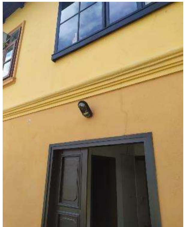
PR-02 (PR-05)....Vertikalna pukotina nadvoja ulaznih vrata. Uglavnom oštećenje žbuke. Mikro pukotine.
