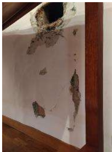
1K-21...Otvori i značajne pukotine uz nosivi zid izloženog prostora. Otvor ispod pete luka svoda nastao u potresu zbog oslabljenja zida zbog dimnjaka.
