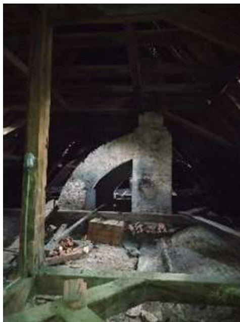
Drvena konstrukcija krovišta sa zidanim dimnjakom
