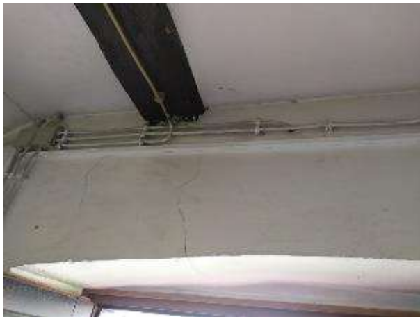
PR-03.....Vertikalna pukotina nadvoja otvora i oko ležaja greda.
