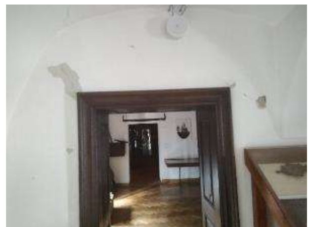
1K-10...Male dijagonalne pukotine oko nadvoja otvora
