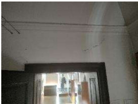
1K-11...Male dijagonalne pukotine oko nadvoja otvora
