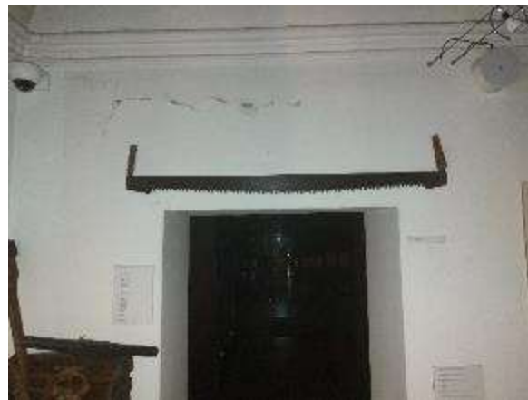
1K-12....Male horizontalne pukotine iznad nadvoja otvora
