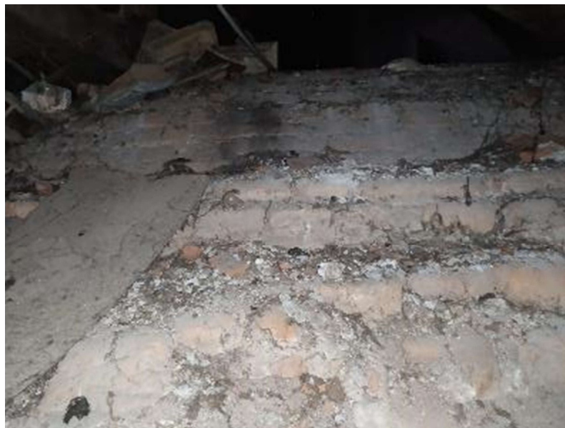
Gornja ploha zidanog lučnog svoda 1 kata – trošna cigla svoda
