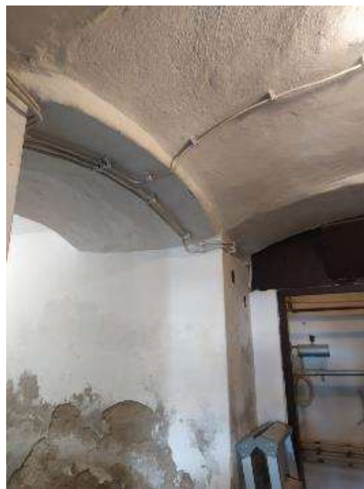
PR-04.....Oštećenja zidova od vlage.
