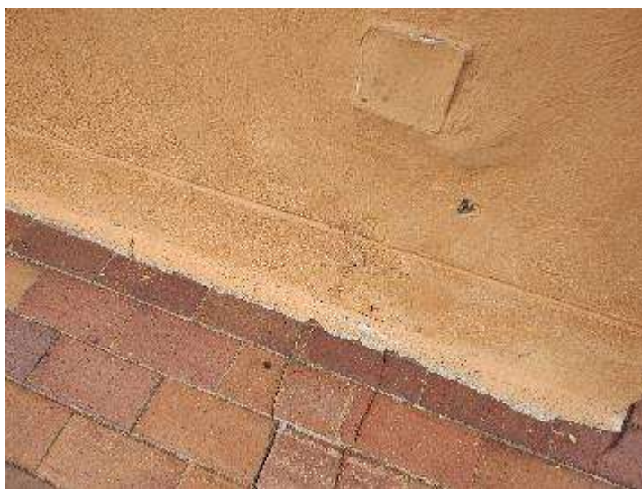
PR-05.....Vertikalna pukotina u soklu vanjskog nosivog zida (mikro pukotina, samo oštećenje obloge fasade)
