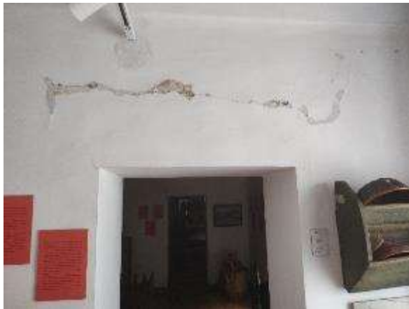
1K-05....Horizontalna i dijagonalne pukotine nadvoja otvora (širine do 1,0 cm)
