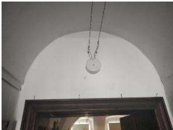
1K-19...Minimalne pukotine svoda otvora glavnog hodnika
