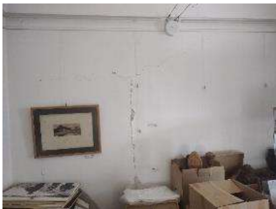
1K-07....Male pukotine do 0,3 cm oko zazidanog otvora
