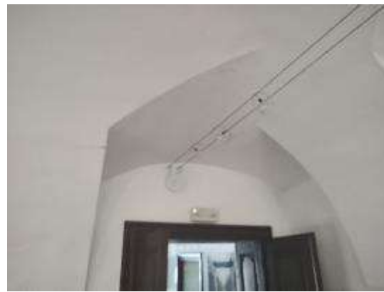
1K-18...Minimalne pukotine svoda otvora glavnog hodnika
